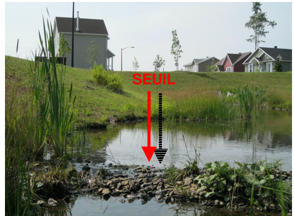
Figure 8. Seuil aménagé au bassin Cassiopée
