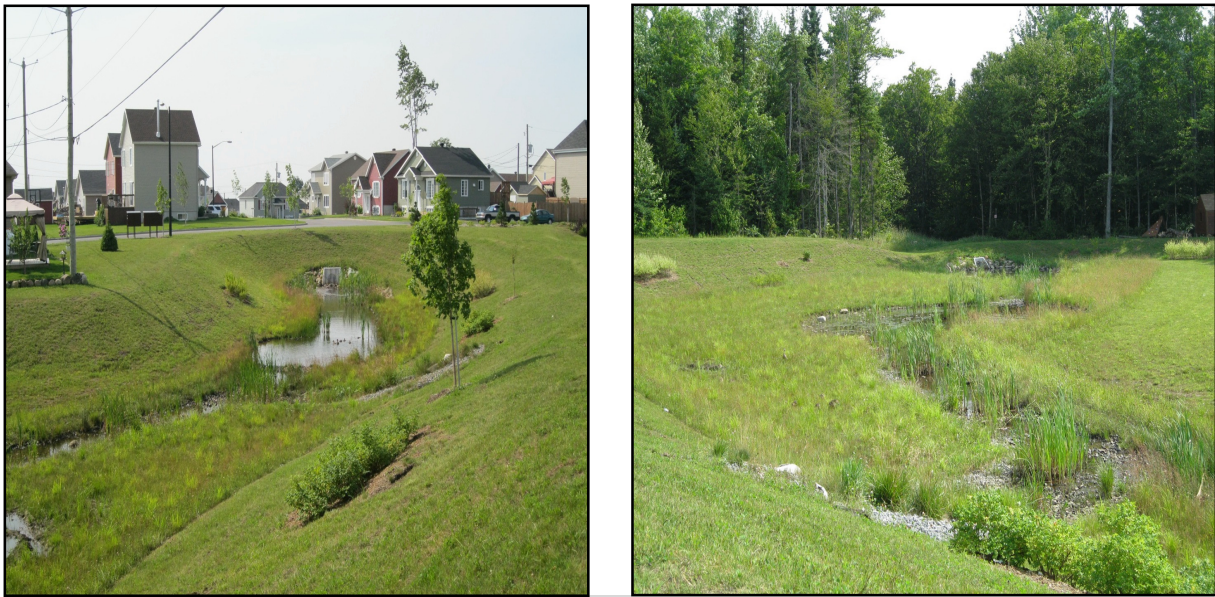
Figure 12. Bassin de rétention Cassiopée avec végétation filtrante, Ville de Québec
