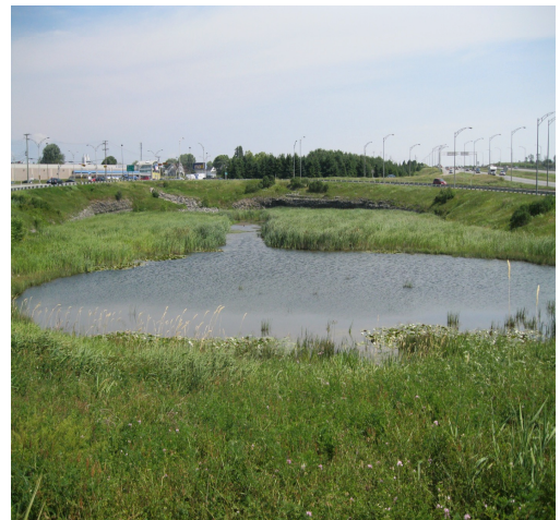
Figure 3. Bassin de rétention ; Autoroute 40 sortie 320 ouest
