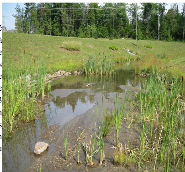
Figure 9. Surplus de sédiments à l'entrée du bassin
