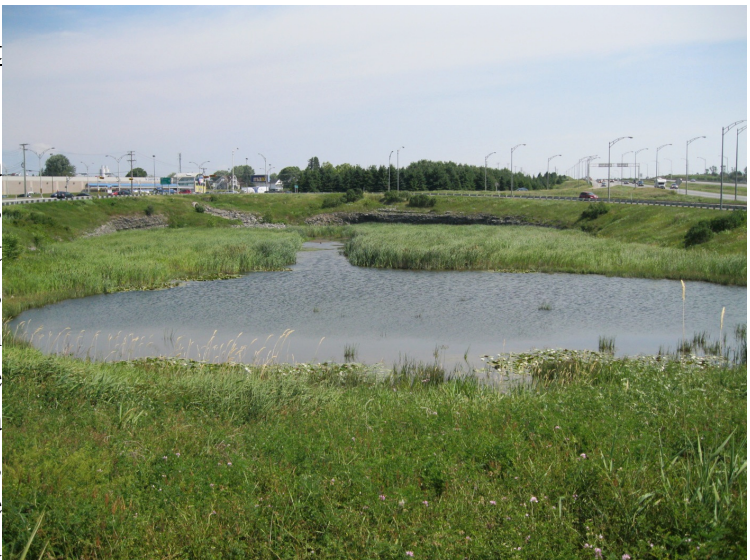
Figure 1. Bassin de rétention; Autoroute 40, sortie 320 ouest
