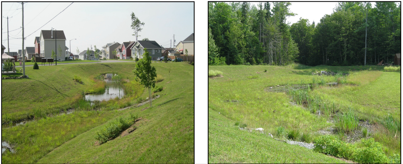
Figure 10. Bassin de rétention Cassiopée avec végétation filtrante, Ville de Québec
