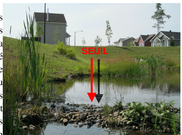
Figure 6. Seuil aménagé au bassin Cassiopée
